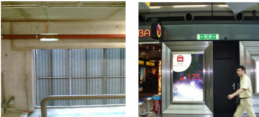
Figuur 13 - Voorbeelden slechte praktijk vluchtwegsignalering
