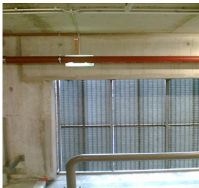
Figure 13 - Exemples de mauvaise pratique en éclairage des signaux de sécurité
