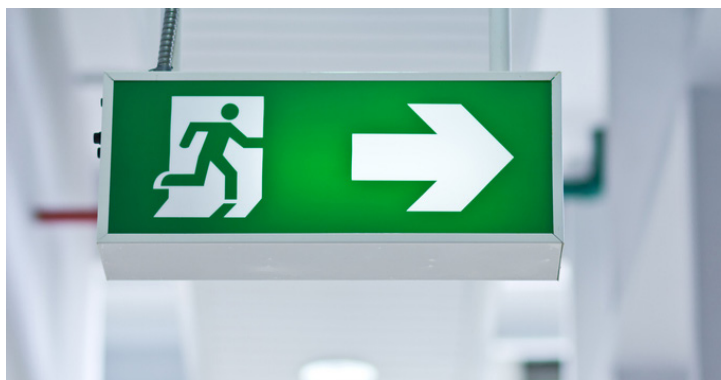
Figure 9 - Éclairage des signaux de sécurité
